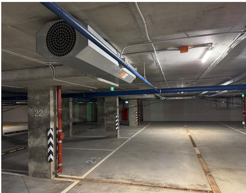
Рис. 5. Струйный вентилятор Р+1 в подземной автостоянке г. Казани
