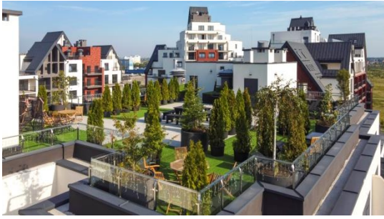
Рис. 6. Эксплуатируемая кровля в каждом доме
