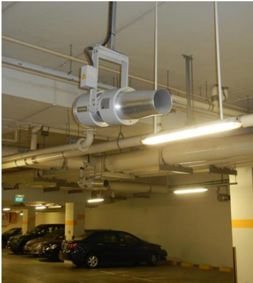
Рис. 6. Устройство крепления струйного вентилятора на стойке с возможностью регулирования углового положения в вертикальной и горизонтальной плоскости
