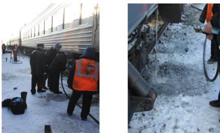
Рис. 6. Поточная обработка систем водотеплоснабжения пассажирских вагонов в эксплуатационном депо
