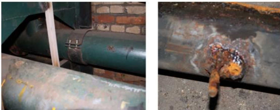
Рис. 6. Состояние сетей ГВС транспортного комплекса. Коррозионные повреждения с наружной стороны, подварки, забитое сечение коррозионно-накипными отложениями
