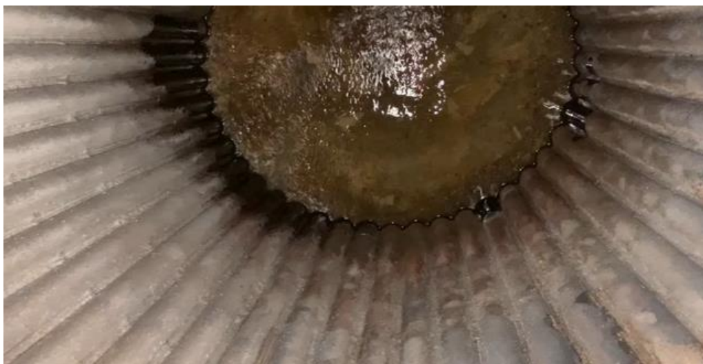
Рис. 10. Состояние 1-го котла на момент заключения договора
