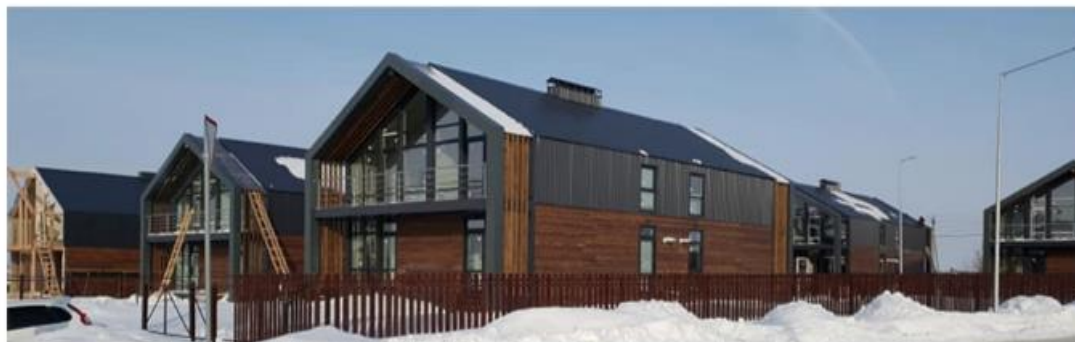
Строительство энергоэффективных домов «ДОН» в проекте «Экодолье Самара»
