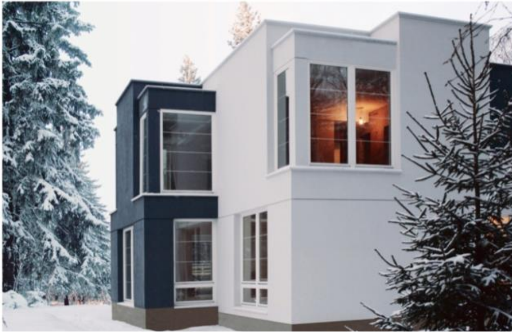
Рис. 4. Первый в России жилой дом площадью 246 кв. м, получивший сертификат немецкого института Passive House, построенный компанией ЗАО «Мосстрой-31» в районе Южное Бутово в Москве (36)
