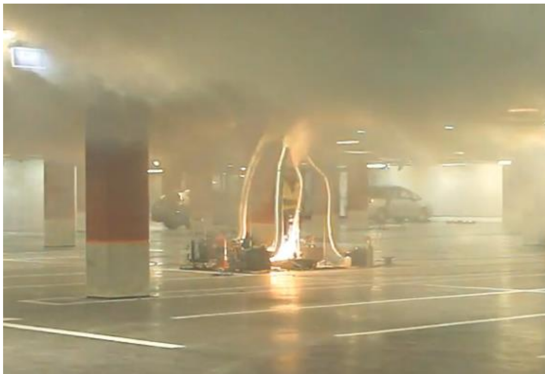
Рис. 7. Испытания противодымной вентиляции в режиме очистки от дыма
