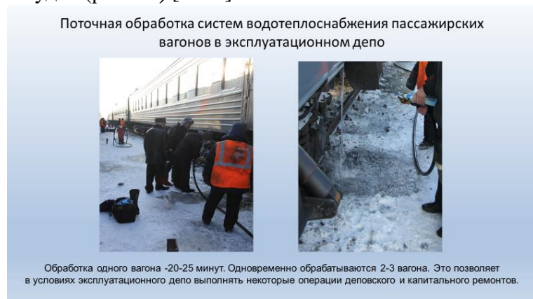
Рис. 16. Поточная обработка систем водотеплоснабжения пассажирских вагонов в условиях эксплуатационного депо с применением ЭМВ
