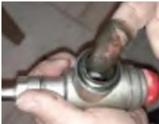
Рис. 6. Вид седимента в разобранном воздухоохладителе из системы теплого пола
