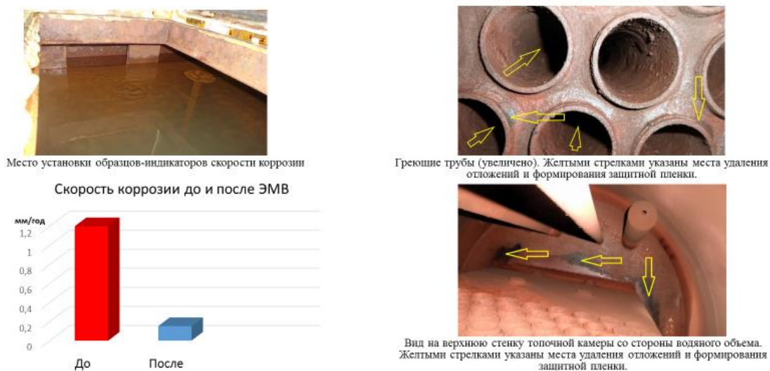
Рис. 5. Изменение состояния водного тракта котельной судна и некоторых параметров ВХР через двенадцать месяцев после обработки
