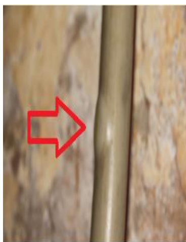
Рис. 1. Образование «отдулин» (указано стрелкой) на поверхности трубопроводов после двух лет эксплуатации. В этом месте произойдет разрушение конструкции
