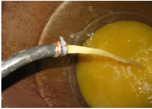
Рис. 9. Промывка системы водой после запуска энергента
