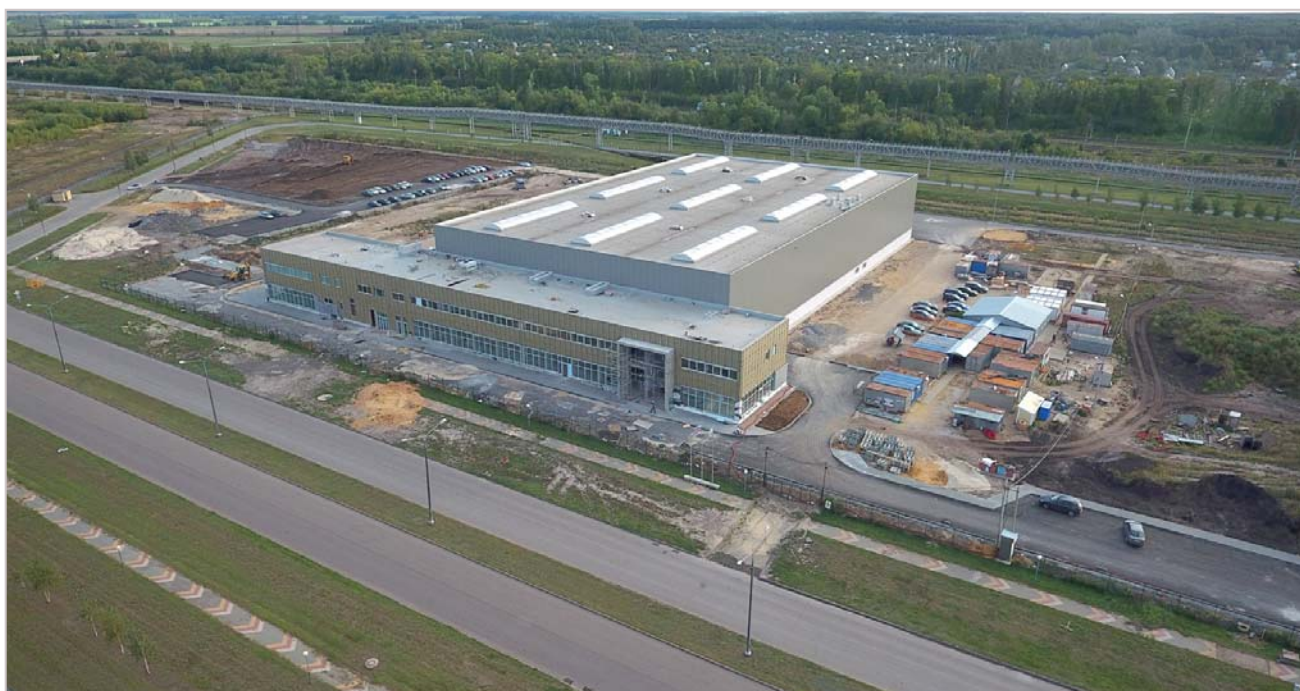
Строительство завода Viessmann в Липецкой области, октябрь 2016
