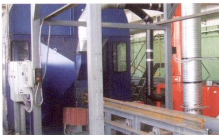
Фото 2. Боковой вытяжной зонт в шлифовальной камере
