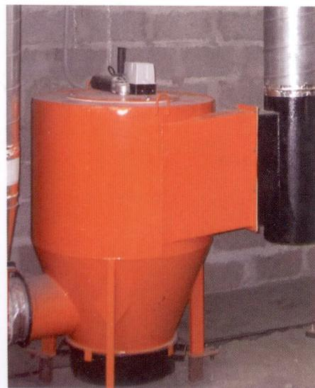
Фото 1. Фильтровально-вентиляционный агрегат ЦФ
